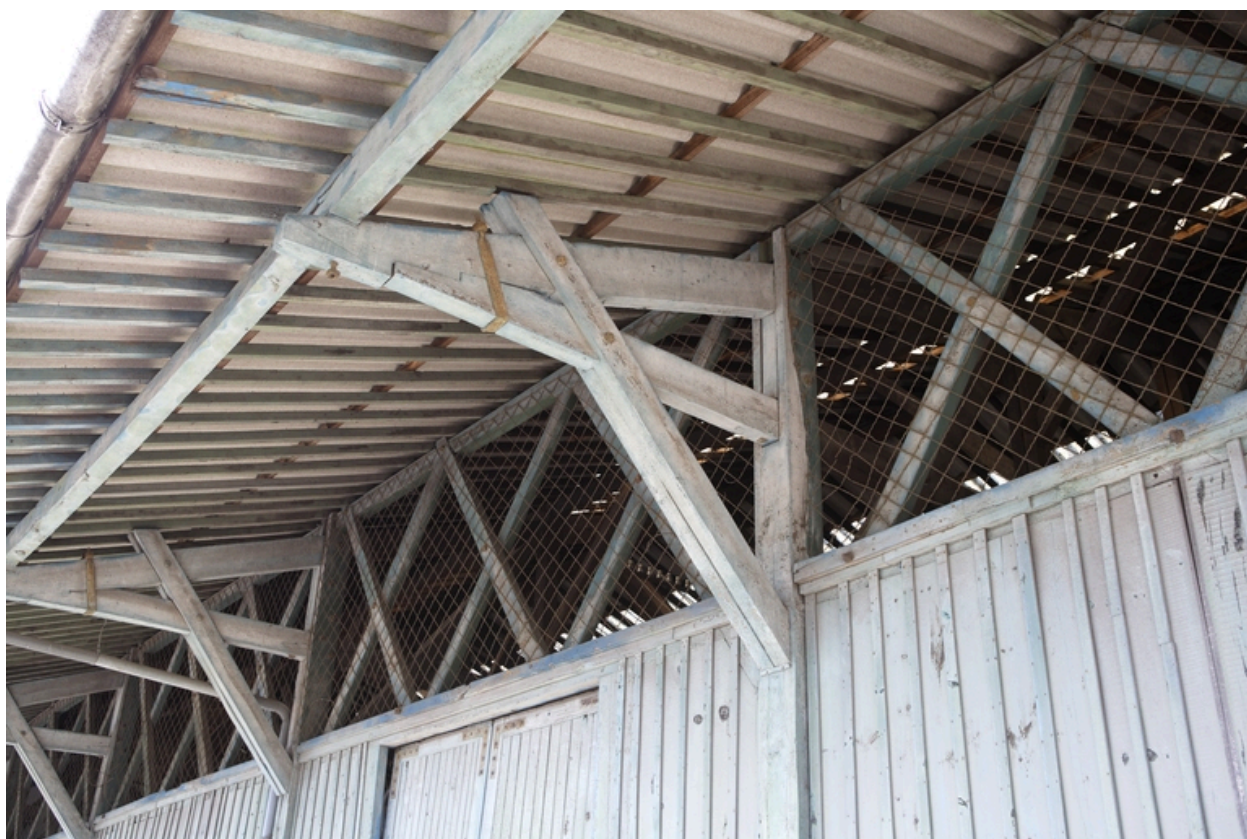
Halle de marchandises : détail de la charpente.
