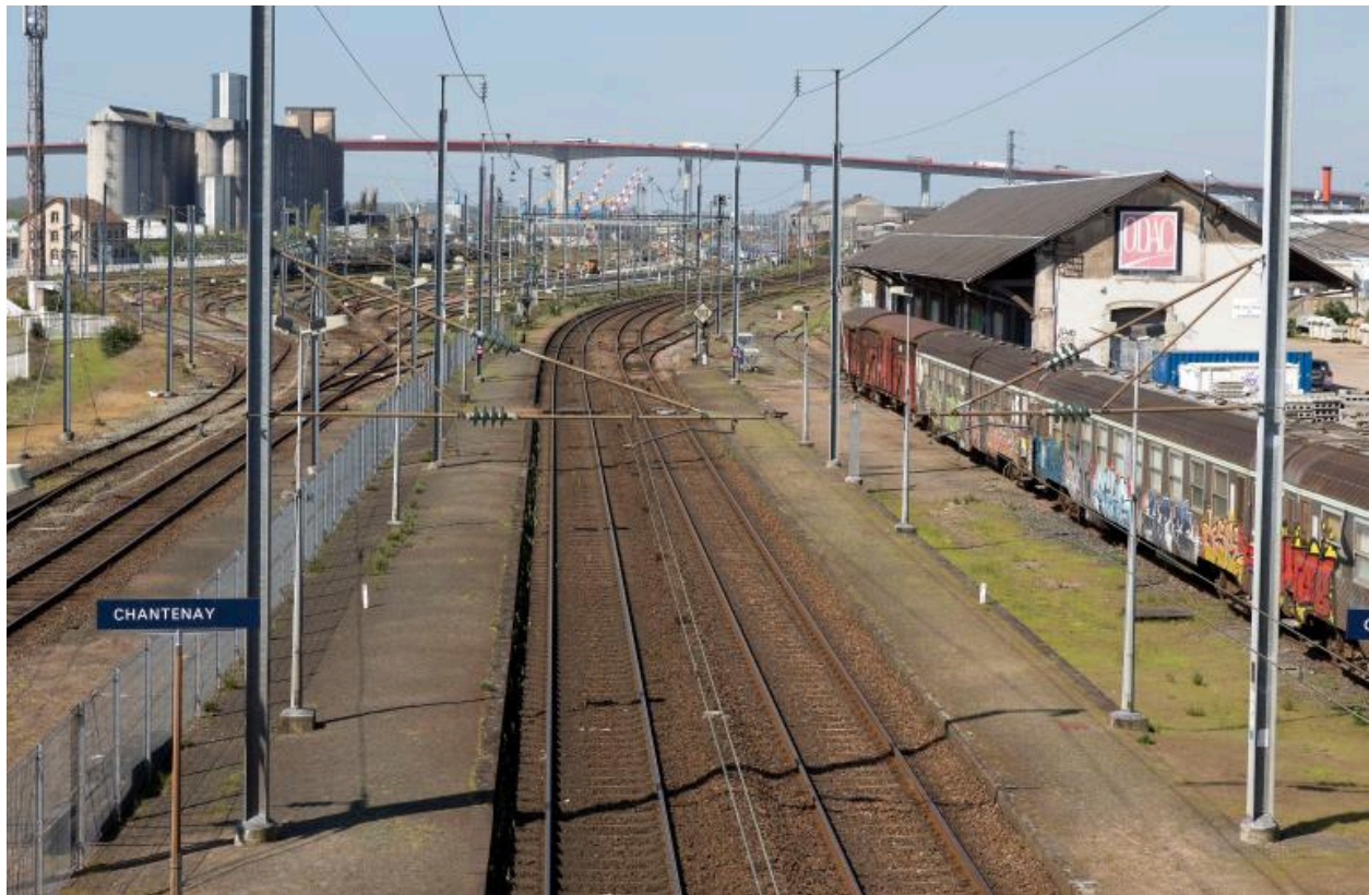
Halle de marchandises et voies en direction de Saint-Nazaire.
