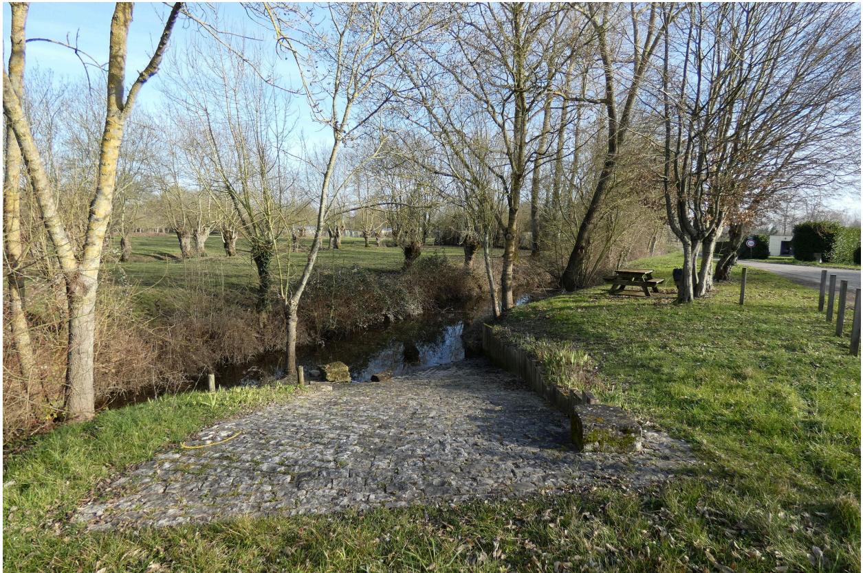
La cale du port vue depuis l'ouest.
