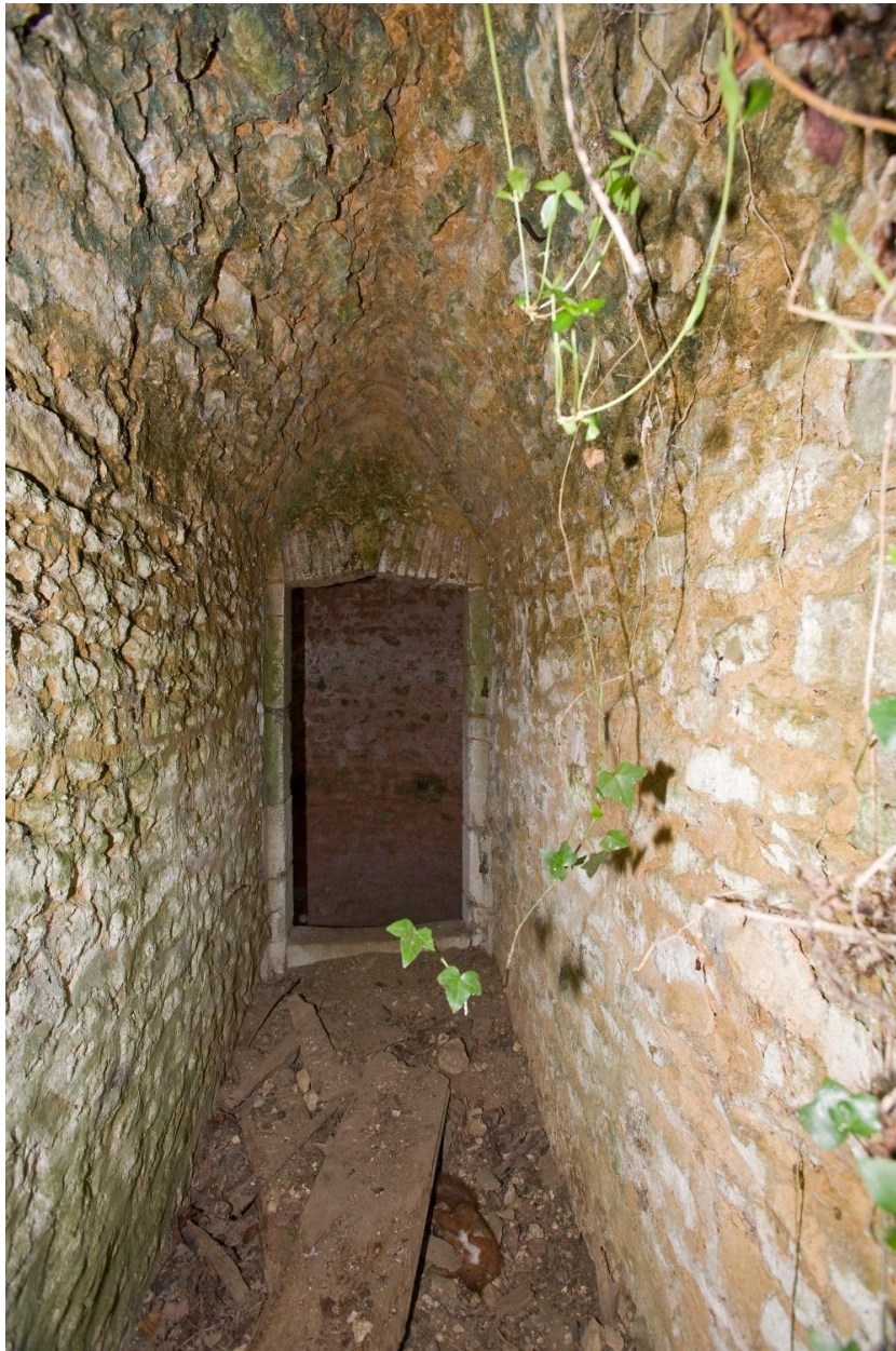
Couloir d'accès à la glacière, vu depuis l'entrée.
