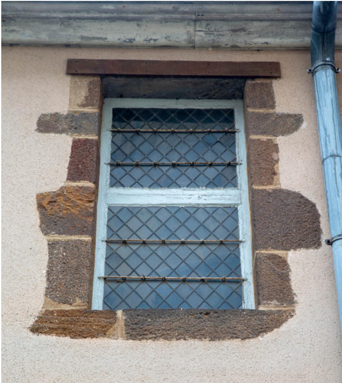
Vue d'une ouverture sur la façade arrière du presbytère.
