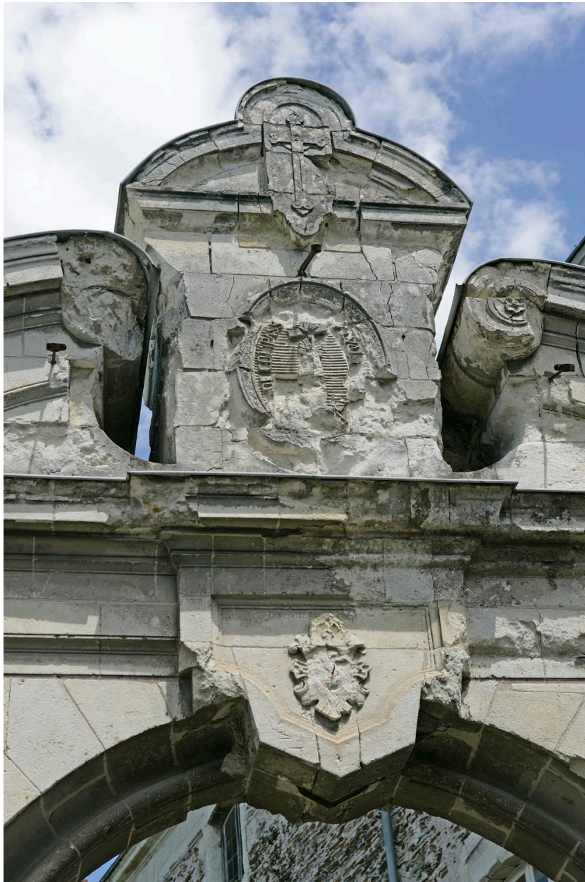
Portail d'entrée de la cour, élévation sur la rue Vauvert : détail du couronnement avec vestiges du blason.
