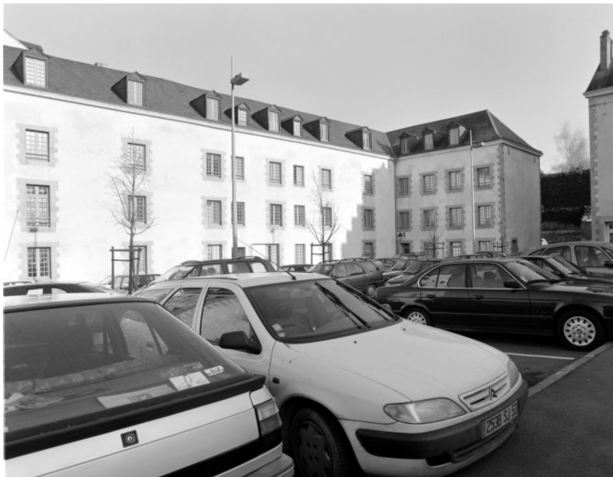
Couvent, corps de logis et aile (après restauration) : vue depuis l'ouest.
