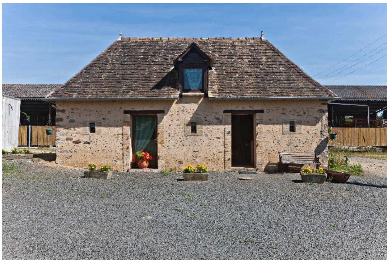
Élévation antérieure des porcheries.
