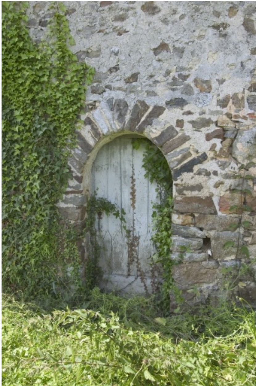
Détail de l'élévation nord : la porte.
