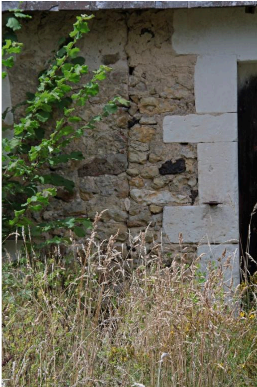
Collage des maçonneries de la maison et de la petite dépendance.
