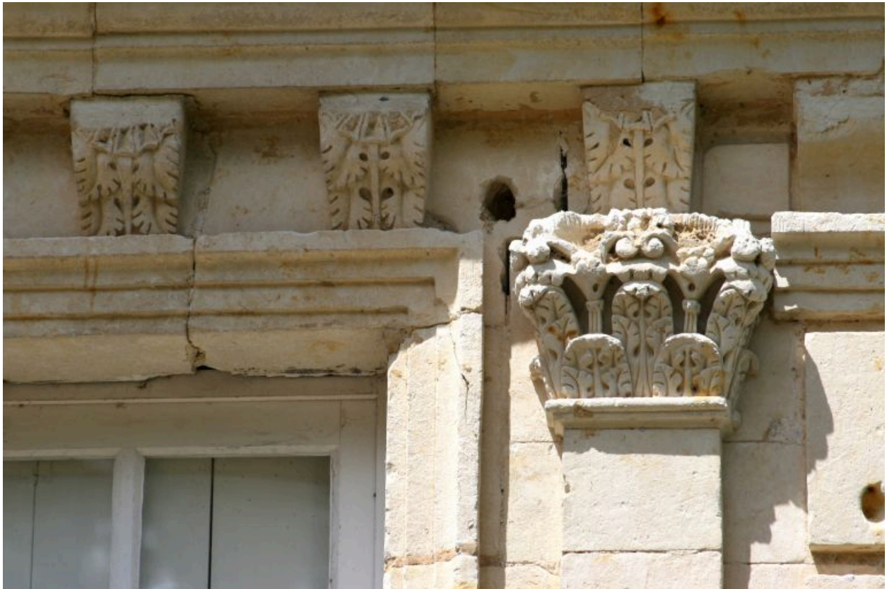
La galerie, baie du premier étage : chapiteau et modillons de la corniche.
