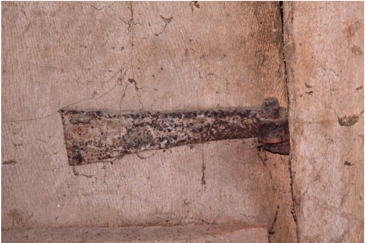
Porte de la cloison du comble : porte de la cloison, gond et penture inférieurs.
