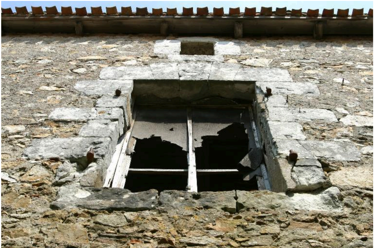
La façade sur l'allée, détail d'une baie.
