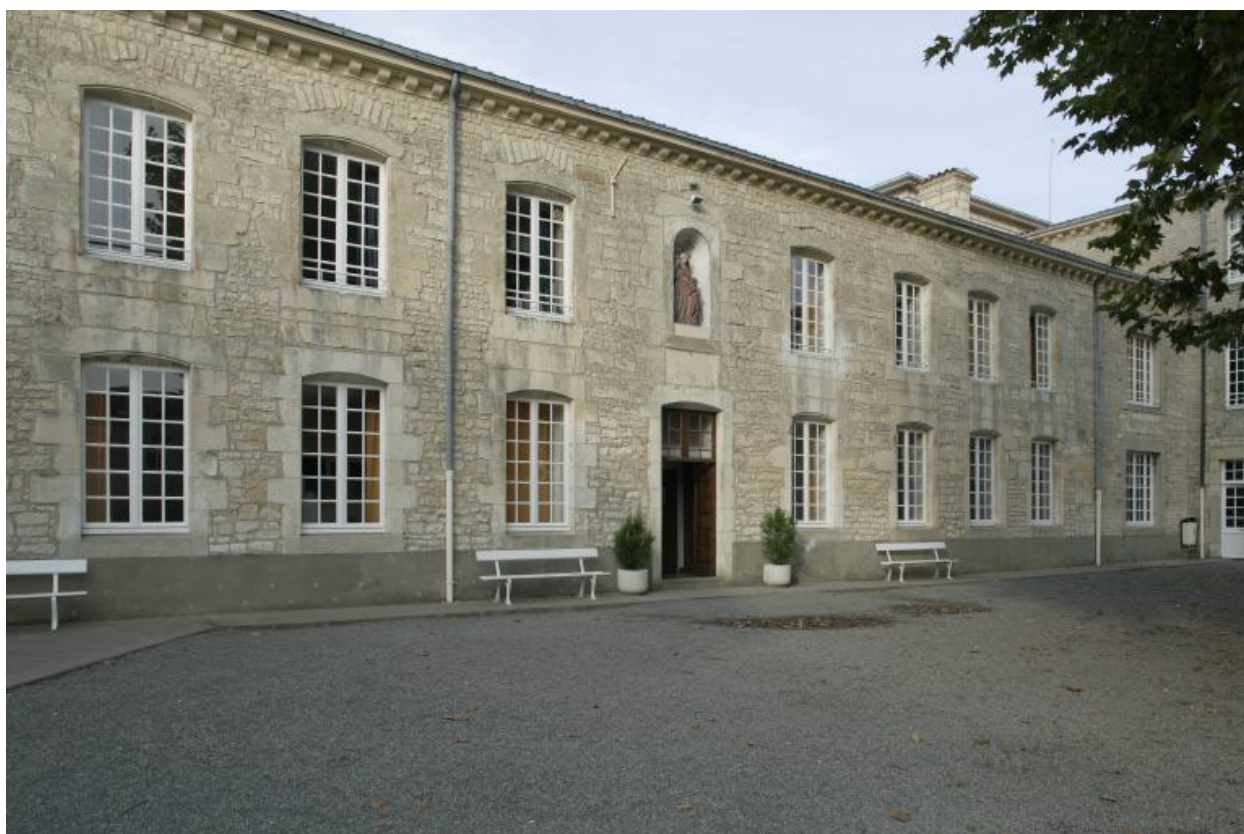
Façade sur cour du bâtiment nord, daté 1777 (pensionnat à l'origine).
