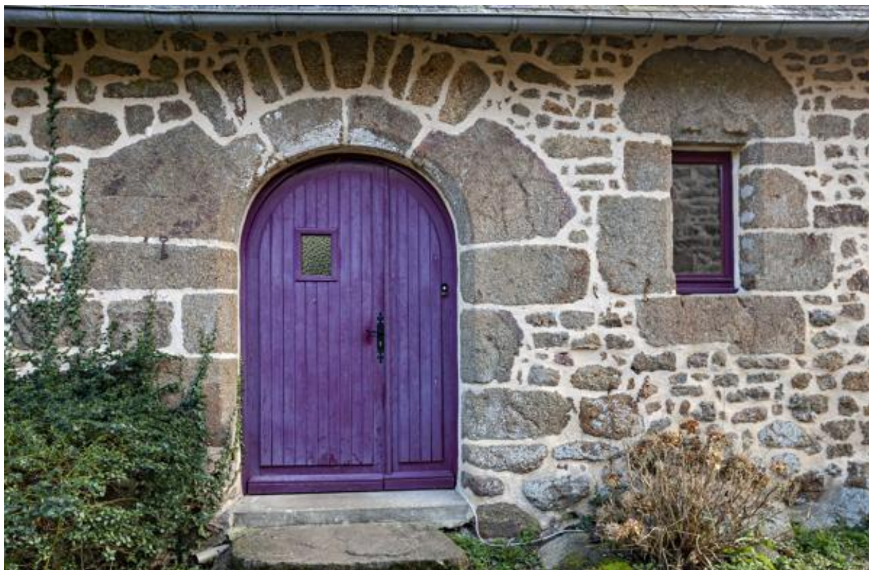
Façade ouest, porte et fenêtre du logis.
