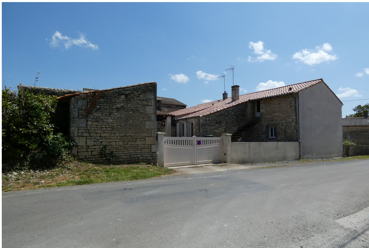
Le logis et la cour nord vus depuis le nord-ouest.
