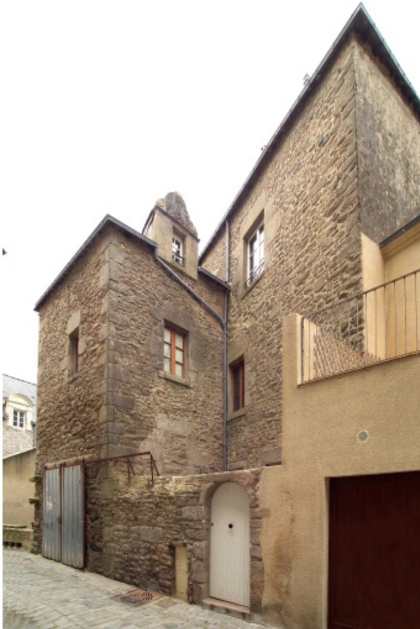
Vue de la partie arrière dans la rue du Saint-Esprit.
