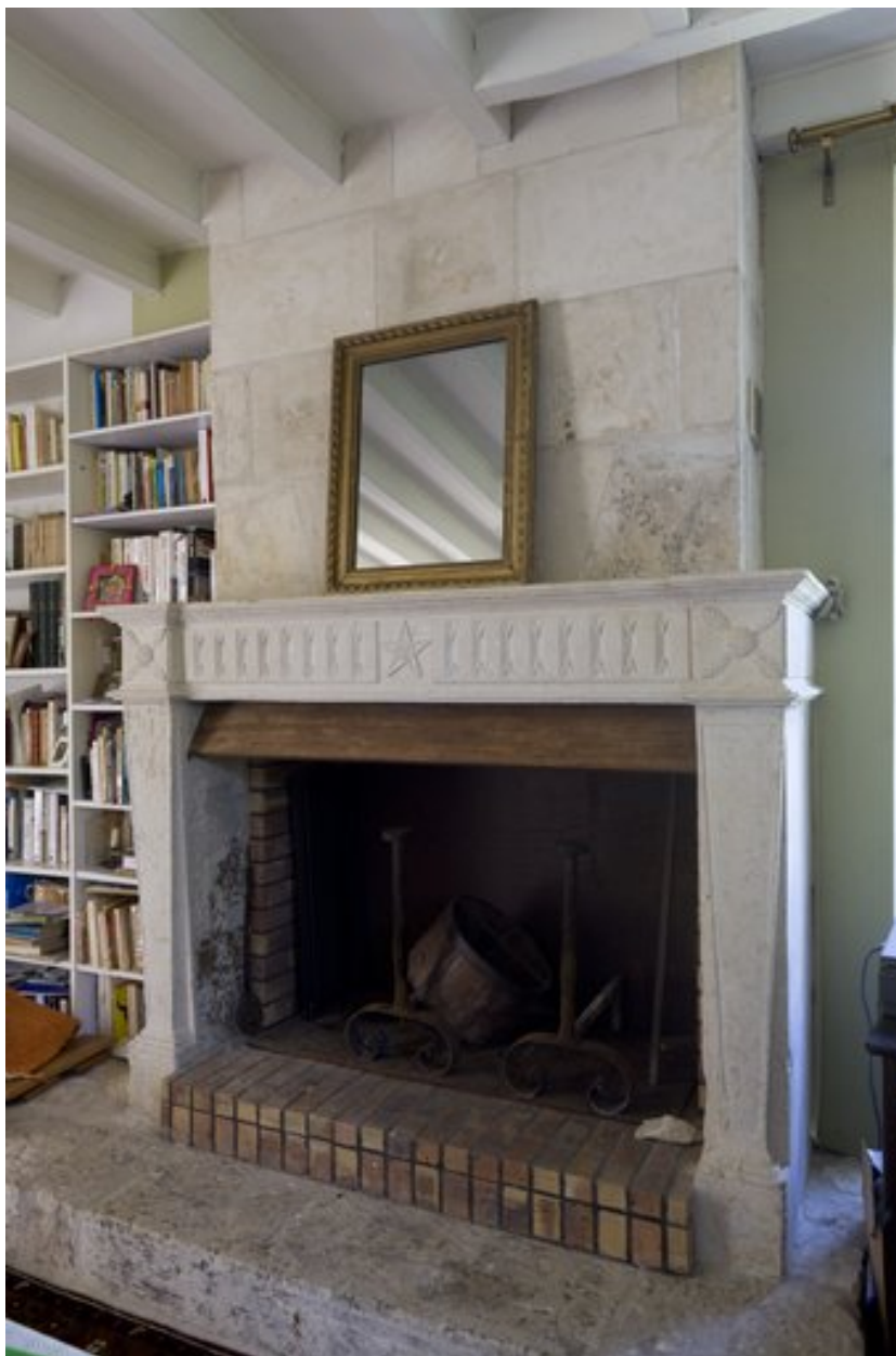
Cheminée de la pièce nord du rez-de-chaussée, provenant d'une autre pièce de la maison.
