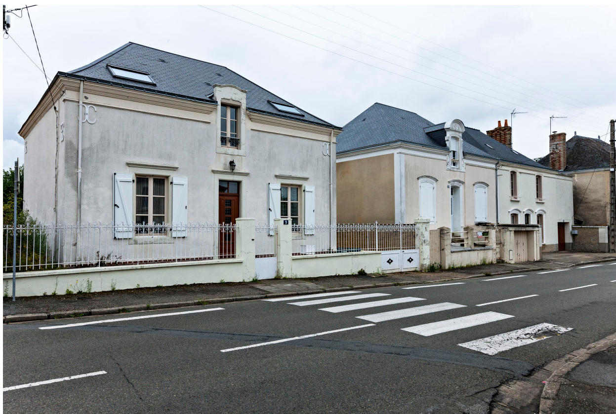
Elévations sur la rue des maisons 5, 7 et 9.
