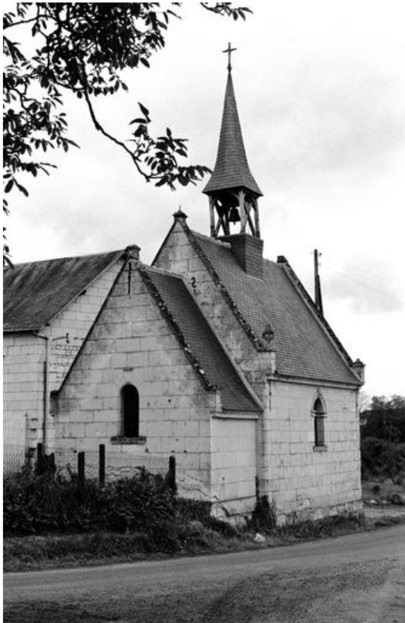
Vue du chevet avant restauration (vue prise en 1979).
