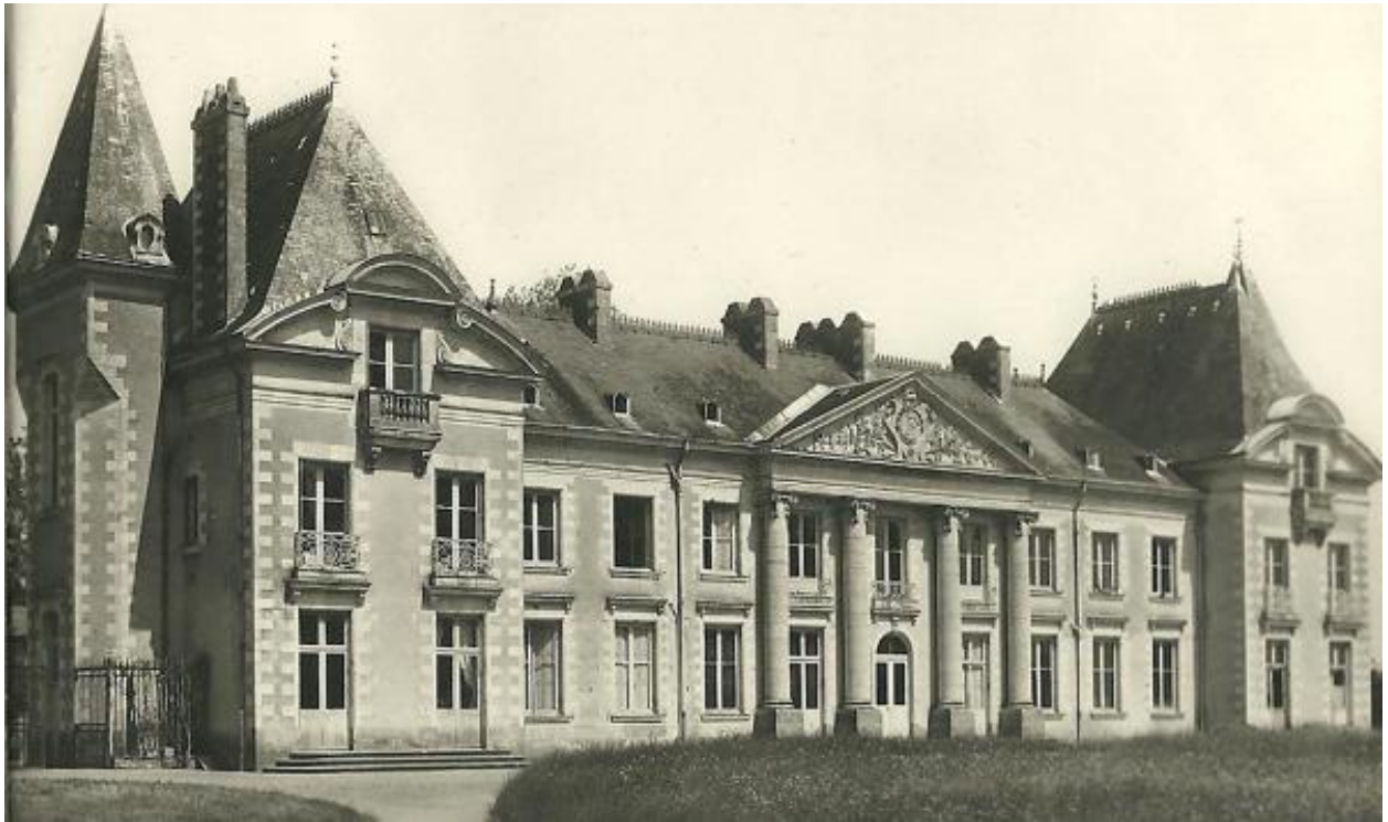
Vue de l'élévation postérieure.
