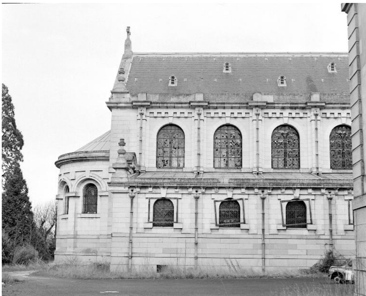
Elévation sud et chevet.
