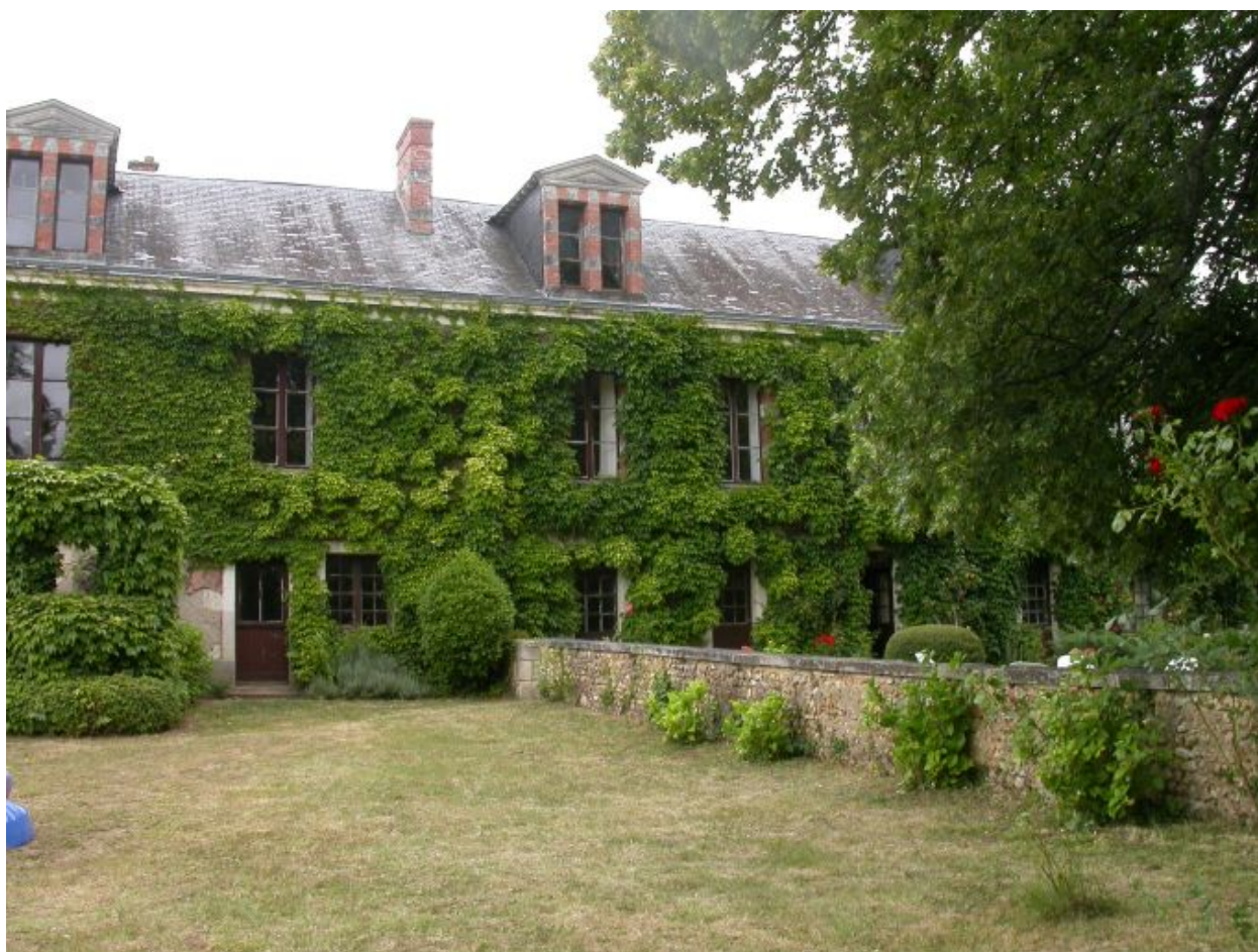
Façade antérieure sur cour.
