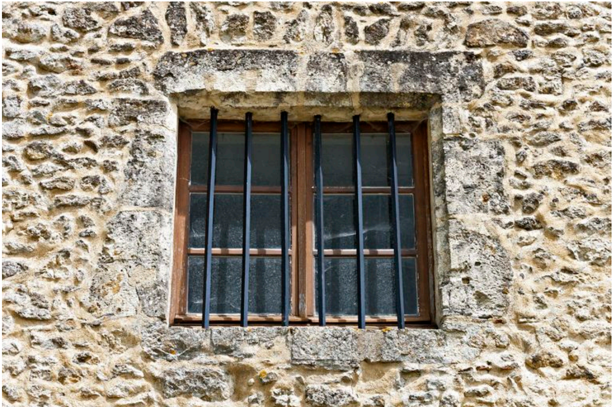
Ancienne croisée (?) de l'étage dans le mur-pignon droit du logis
