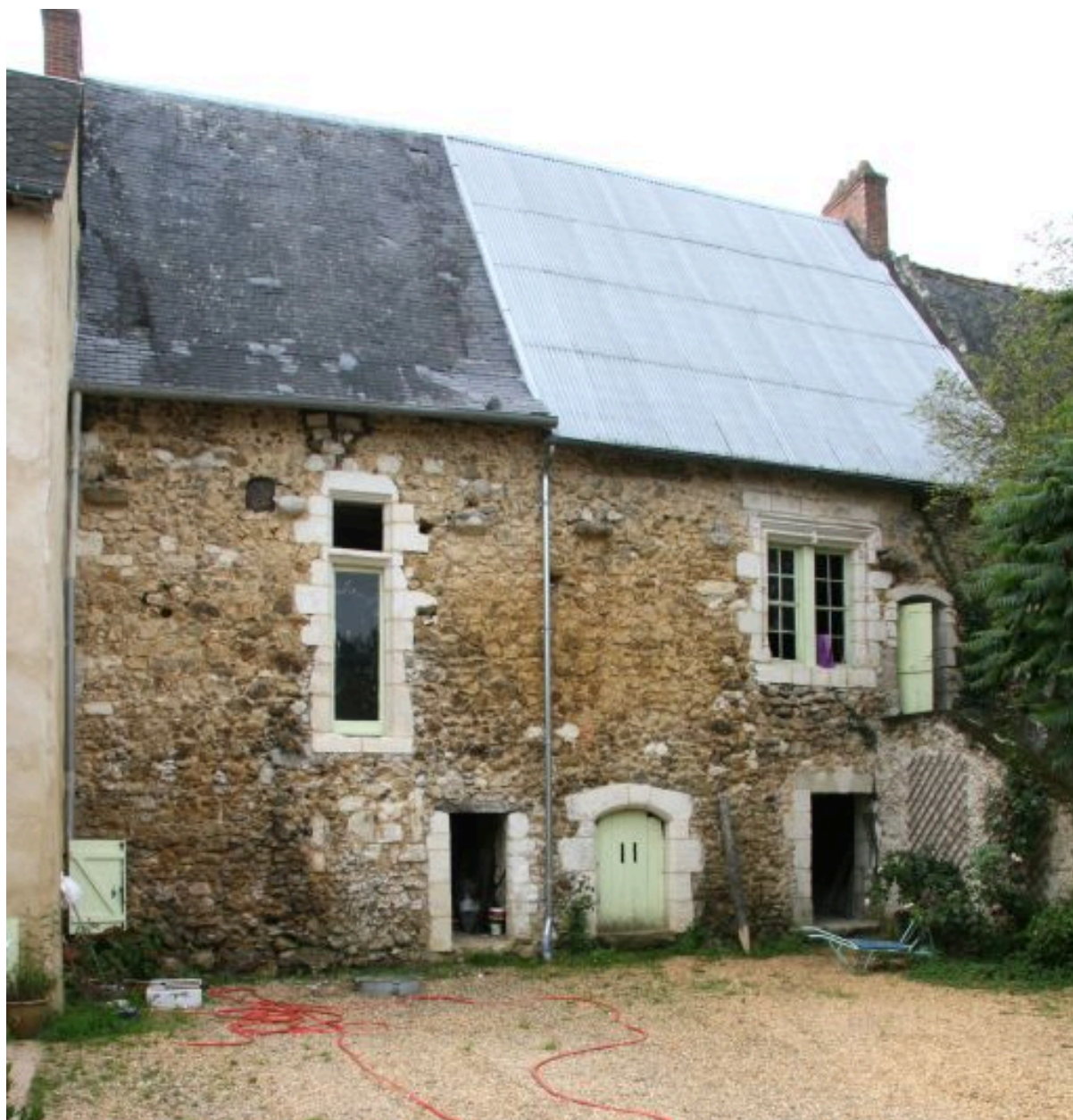
Façade antérieure sur cour.
