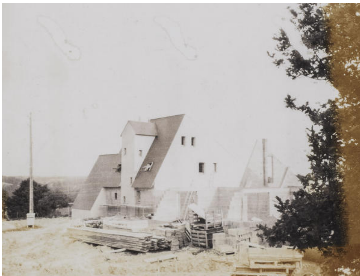
La maison en construction, 1978.
