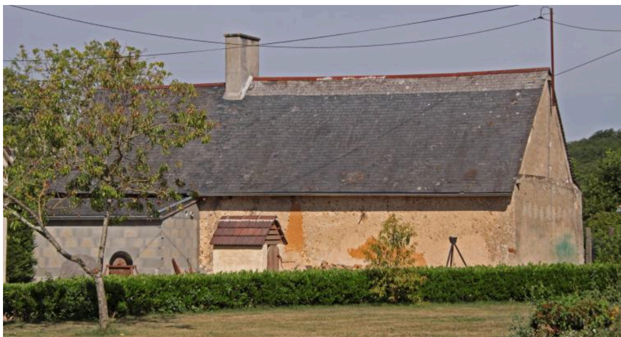
Maison n°13 : vue de volume de la façade postérieure.
