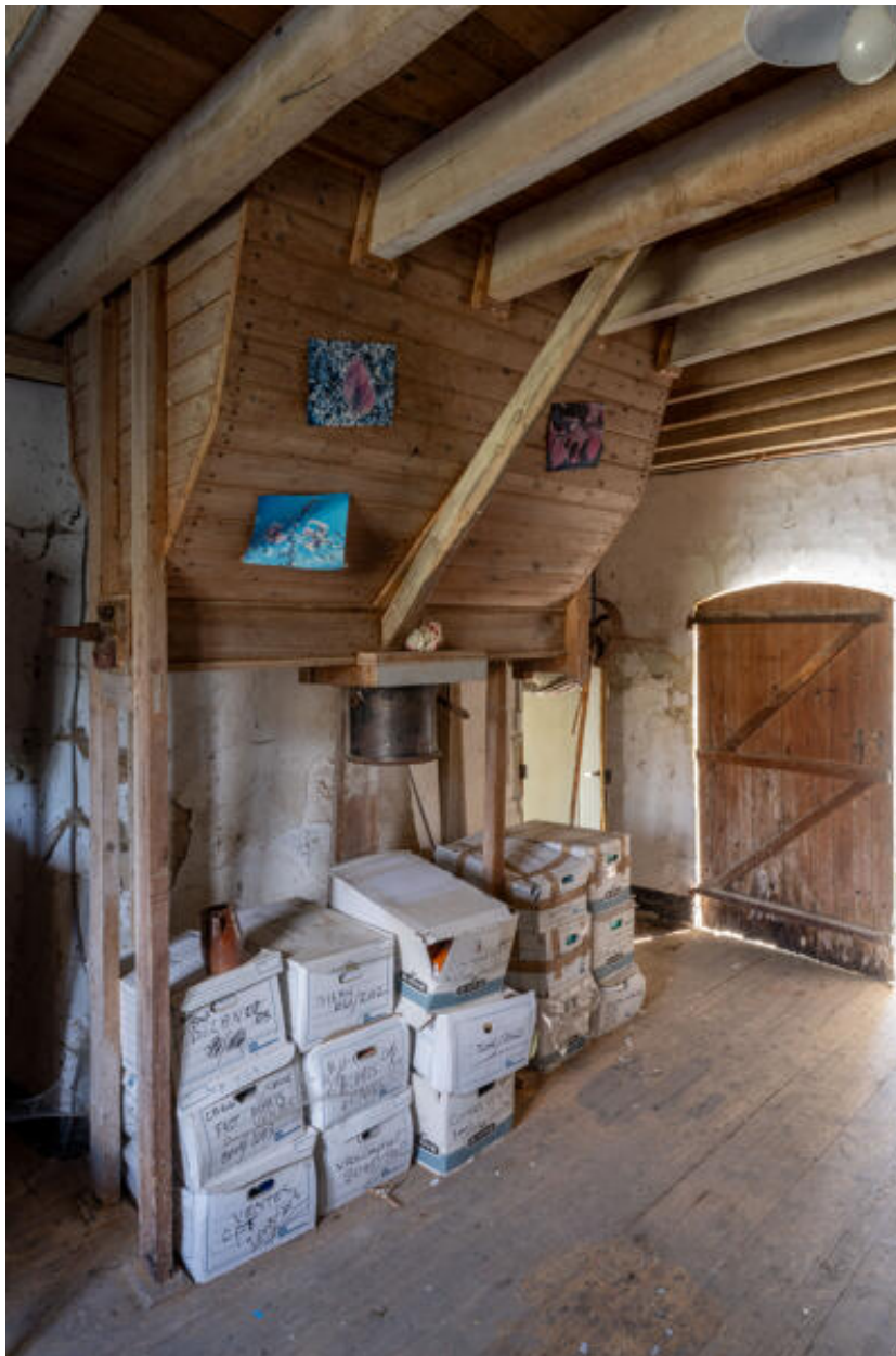
Machines du moulin, premier étage : chambre à farine.
