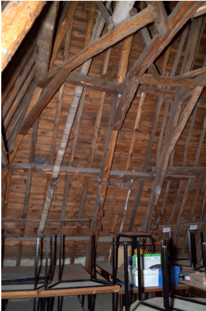
Charpente de l'aile est.
