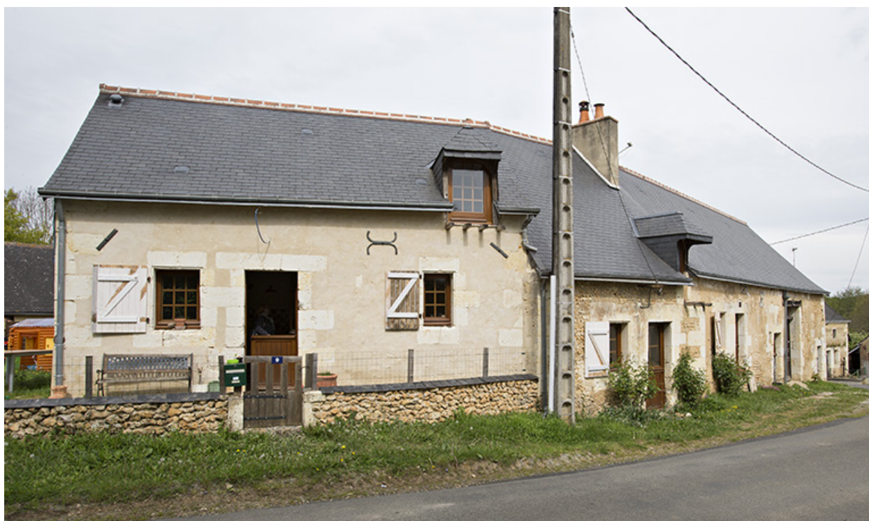
Maison et ferme bloc à terre accolées.
