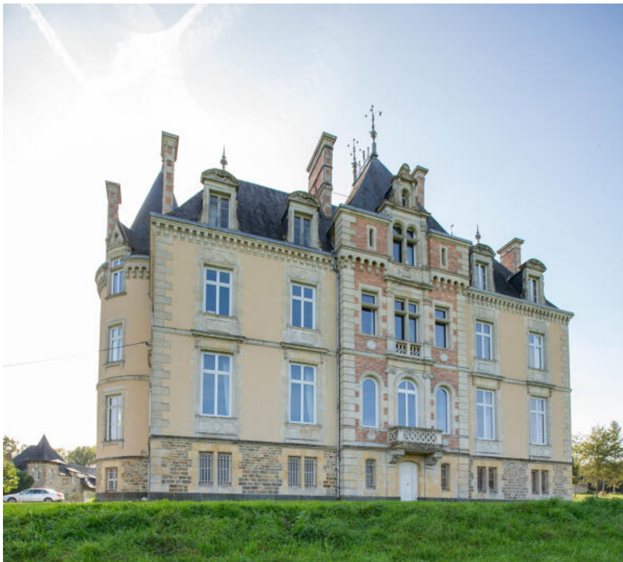
L'élévation postérieure du château.
