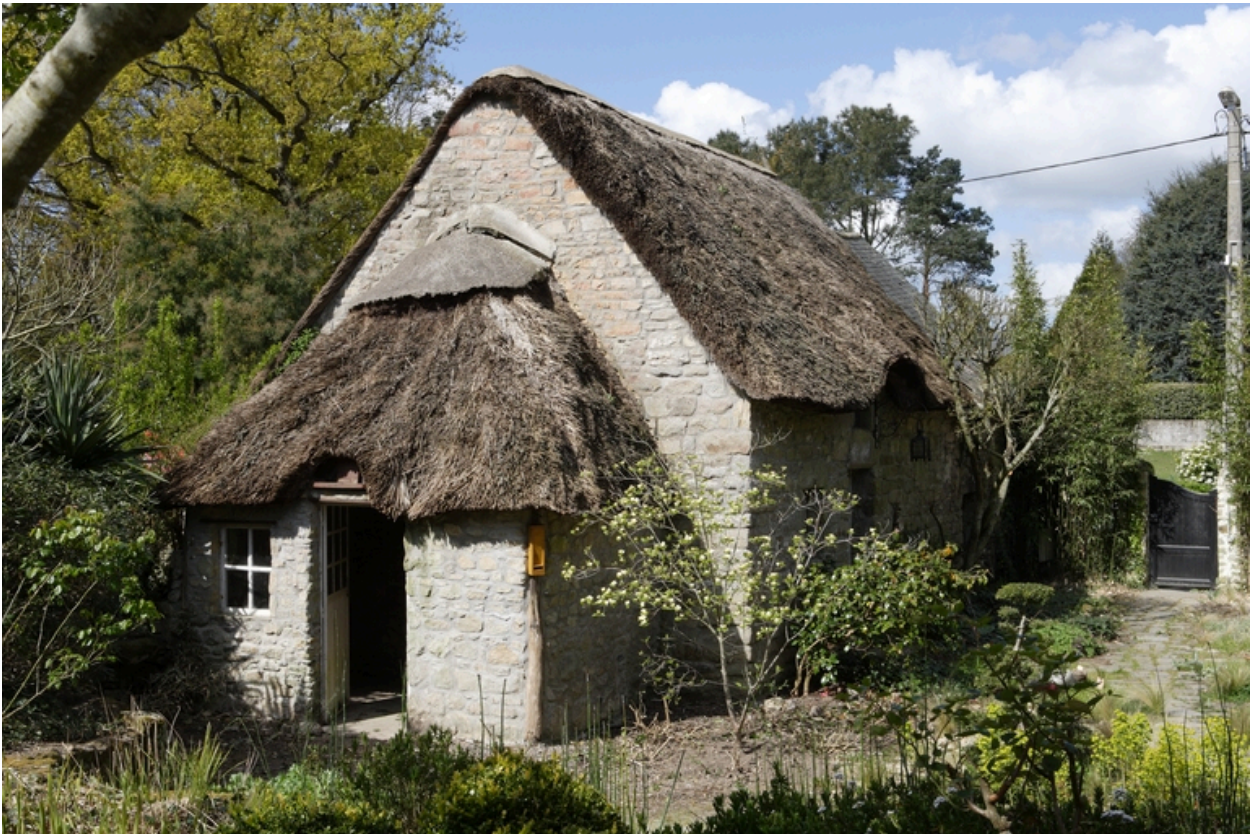
Vue de l'écurie depuis l'ouest.
