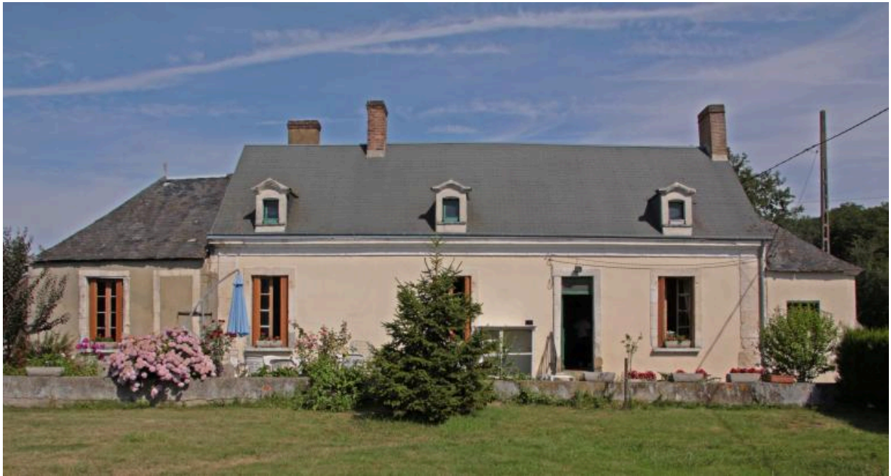
Maison n°9 : façade antérieure sur cour.
