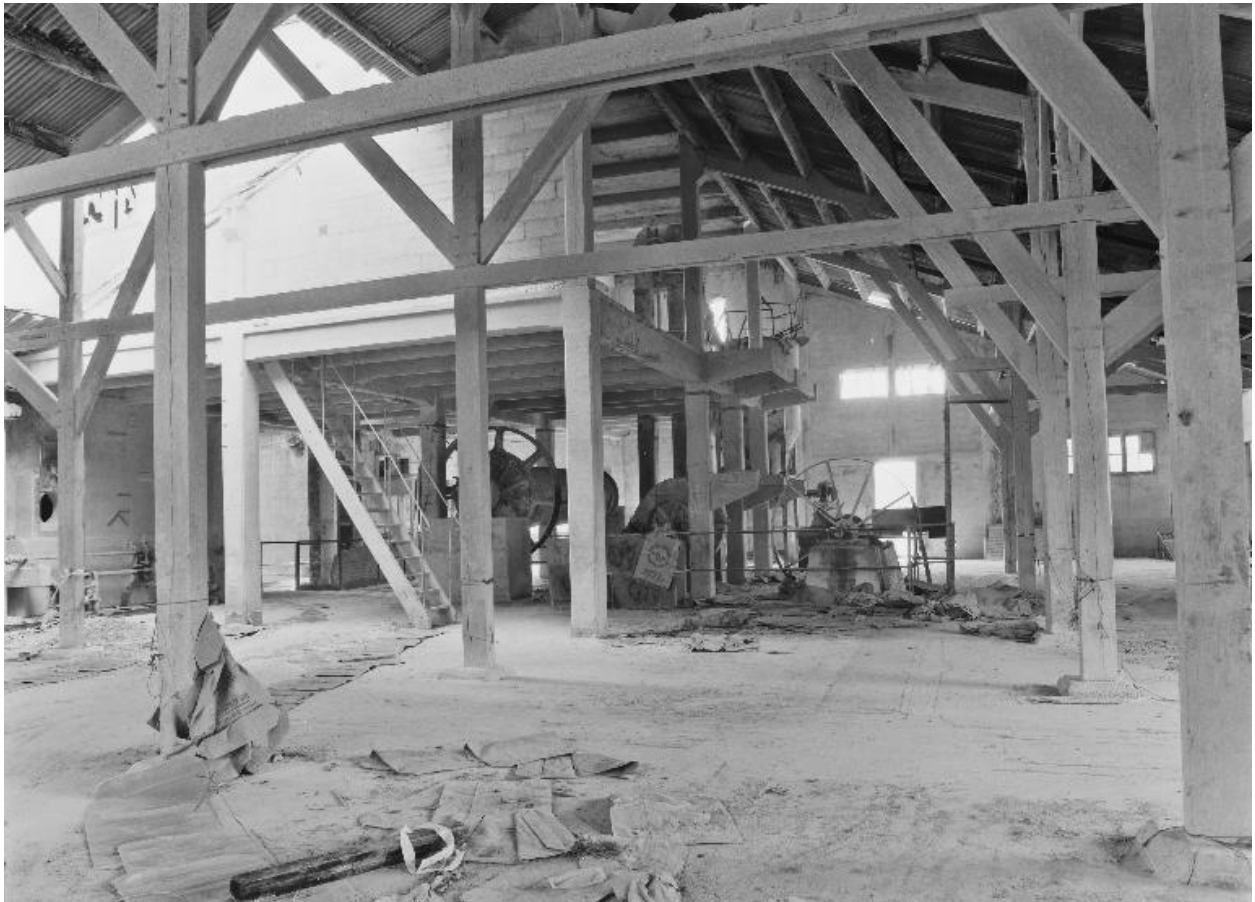
Usine de chaux ; vue intérieure de l'atelier de blutage
