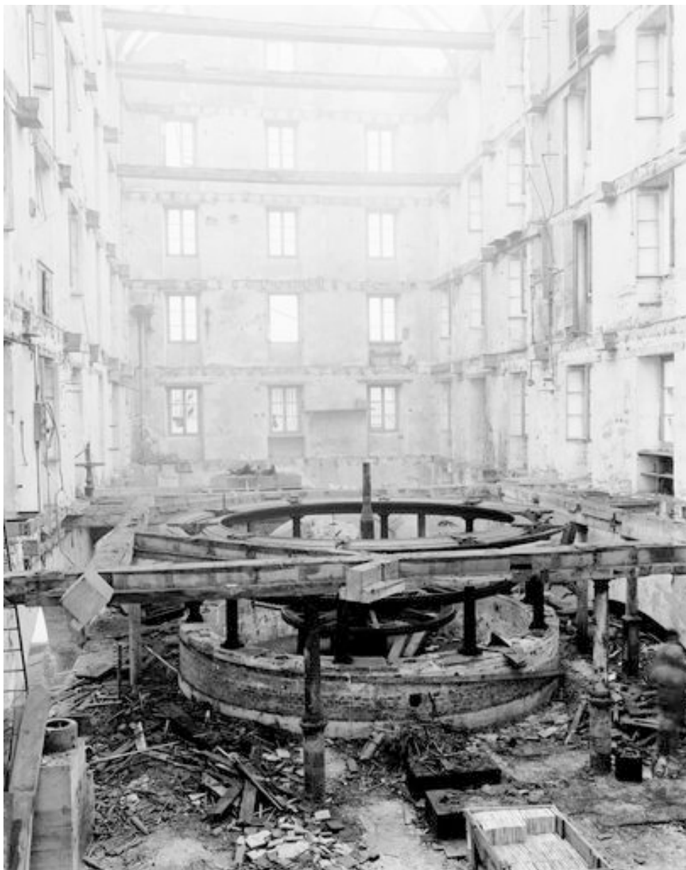
Bâtiments A ; Vue d'ensemble de l'élévation intérieure d'ouest en est.
