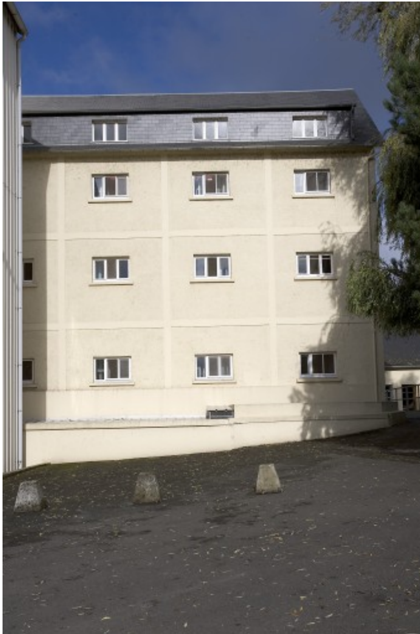
La minoterie vue depuis le sud-est.
