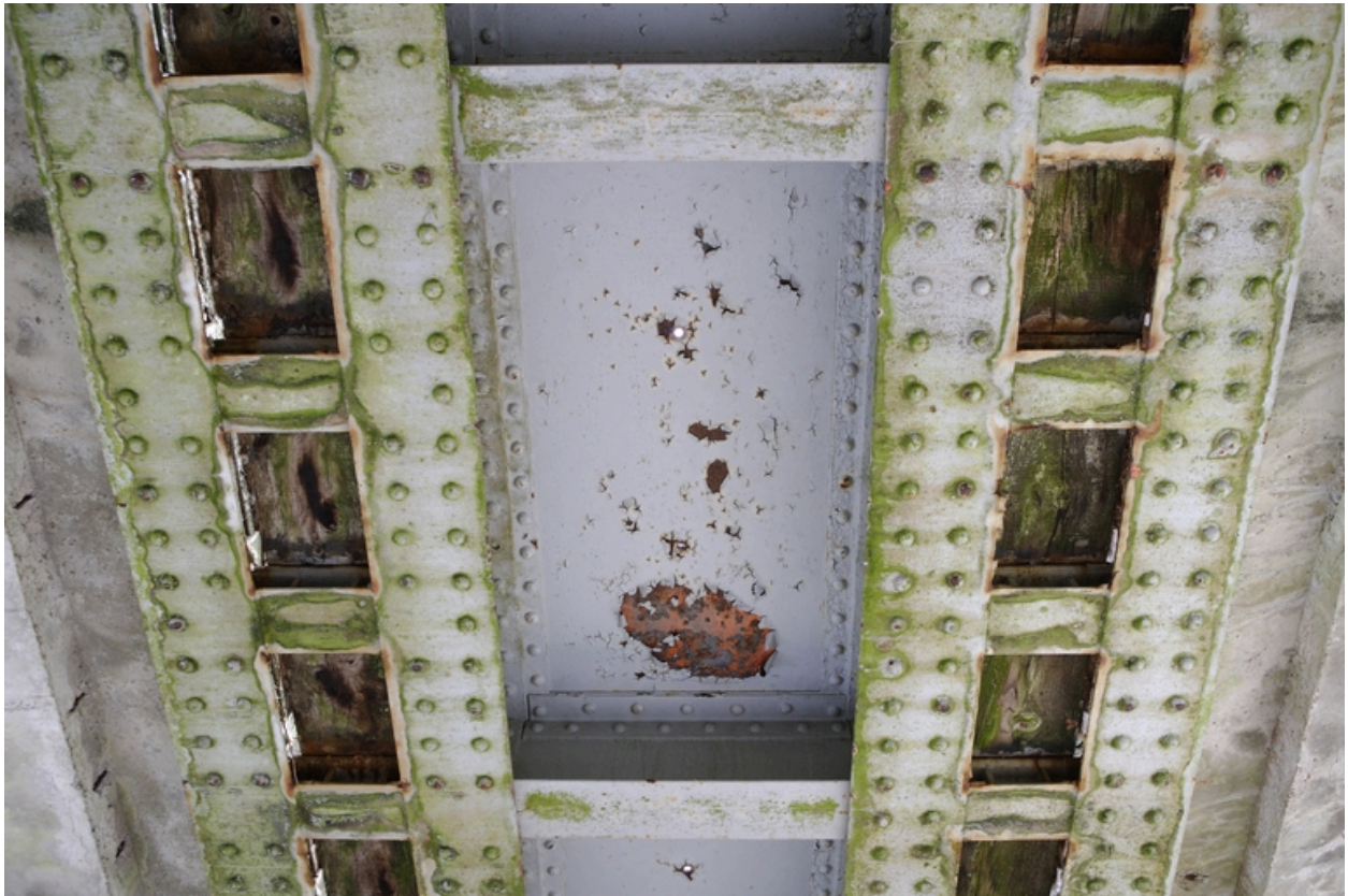
Poutres et entretoises, vue inférieure.
