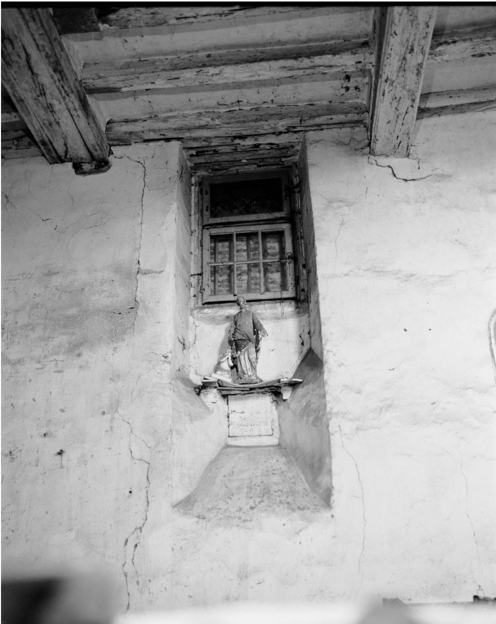
Bâtiment dit des lieux communs, rez-de-chaussée, pièce est : fenêtre du mur nord.
