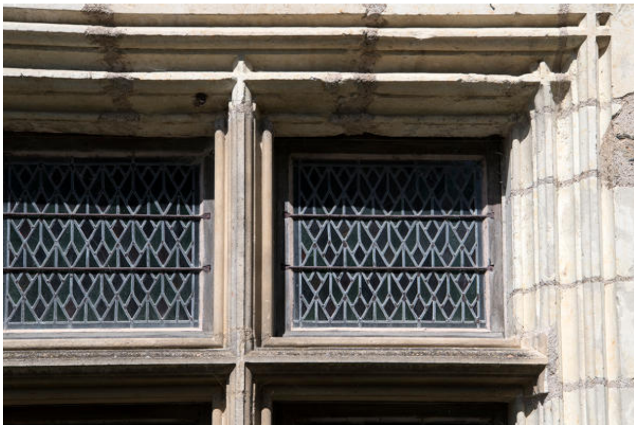
Détail des moulures de la baie du rez-de-chaussée du logement du prêtre.
