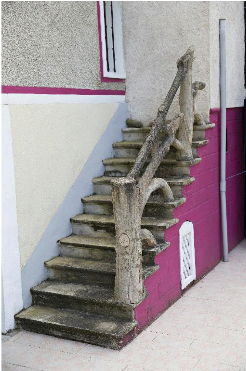
Façade postérieure : escalier extérieur.
