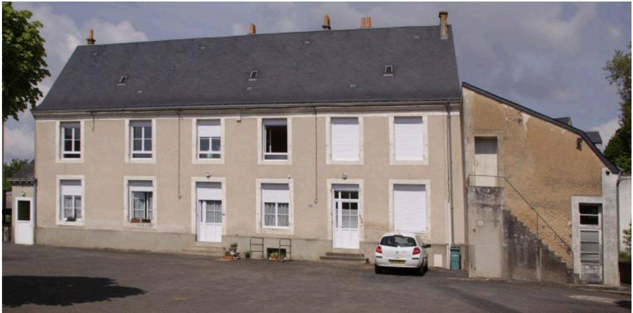
Façade antérieure sur cour.
