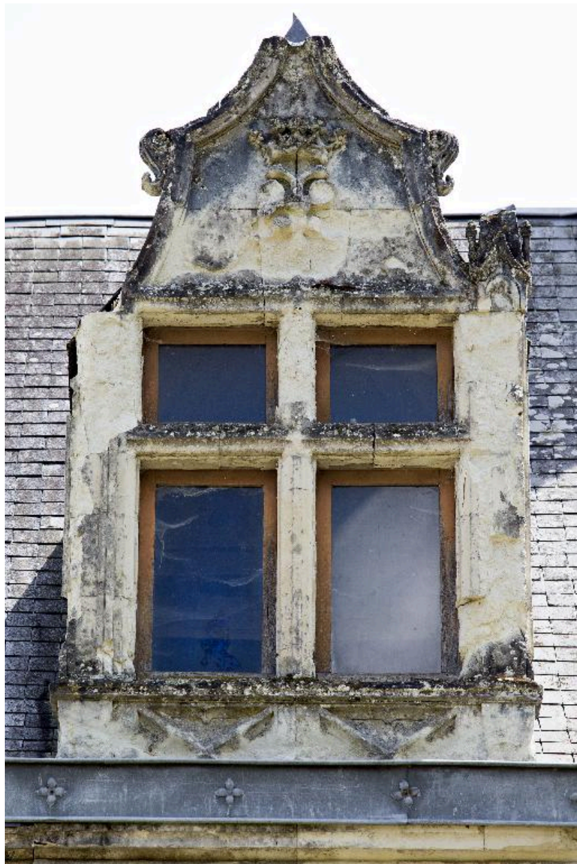
Lucarne de l'élévation sud : avant-avant-dernière travée à droite.
