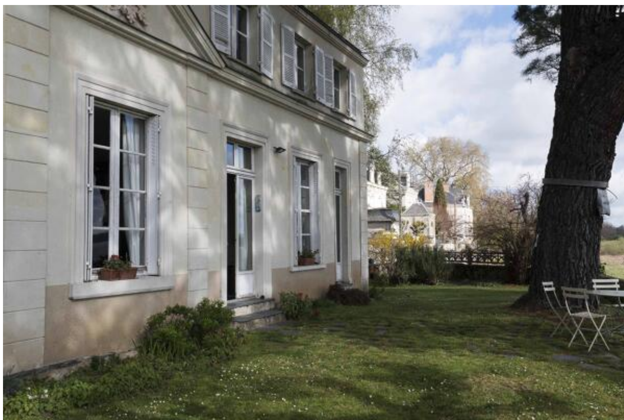
La villa Saint-Paul. Vue de la façade sur Loire depuis le sud-est.
