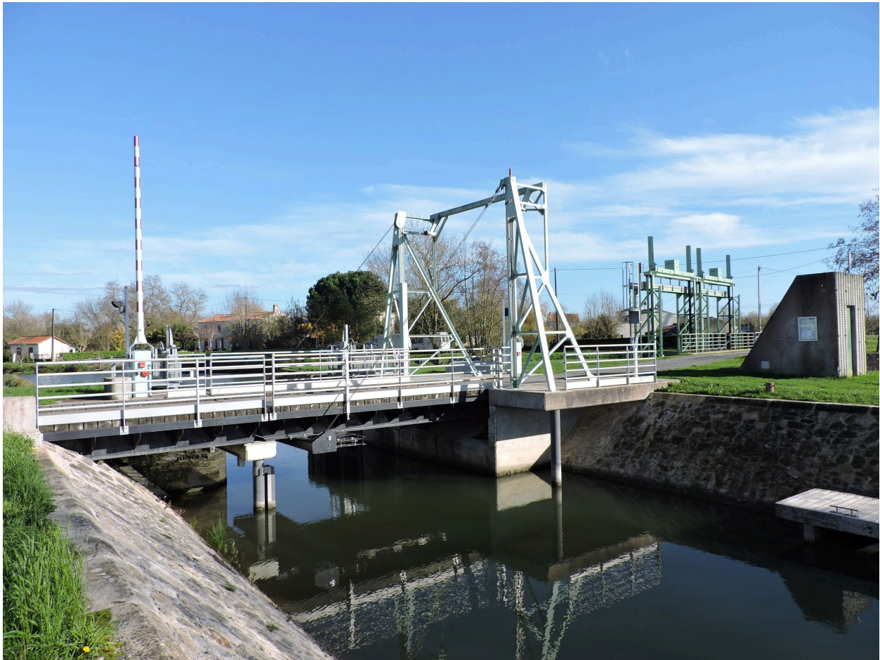
Le pont-levis par-dessus l'écluse, vu depuis l'ouest.
