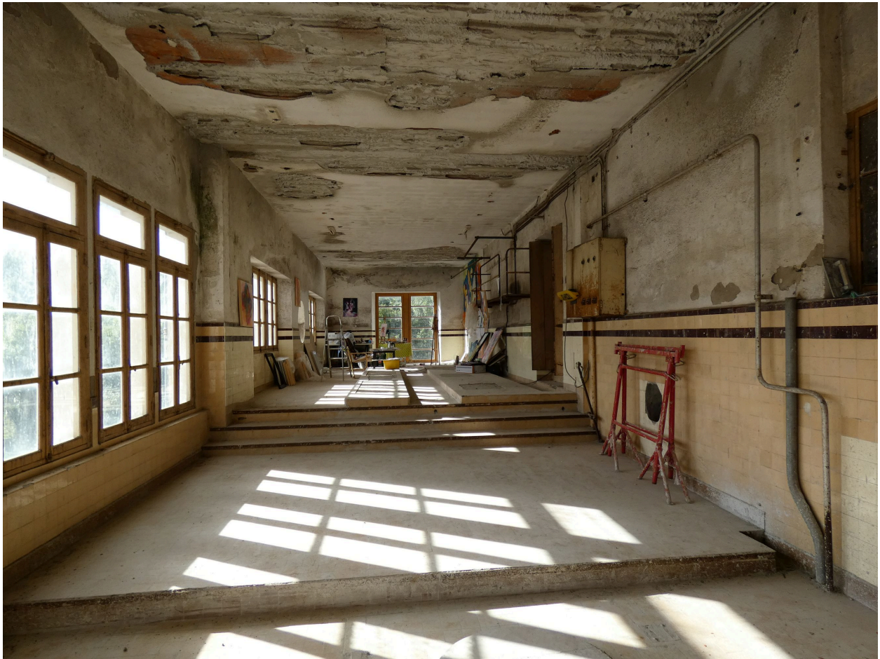
Salle à l'étage du magasin à poudre de lait et de la chaufferie, vue depuis le nord.
