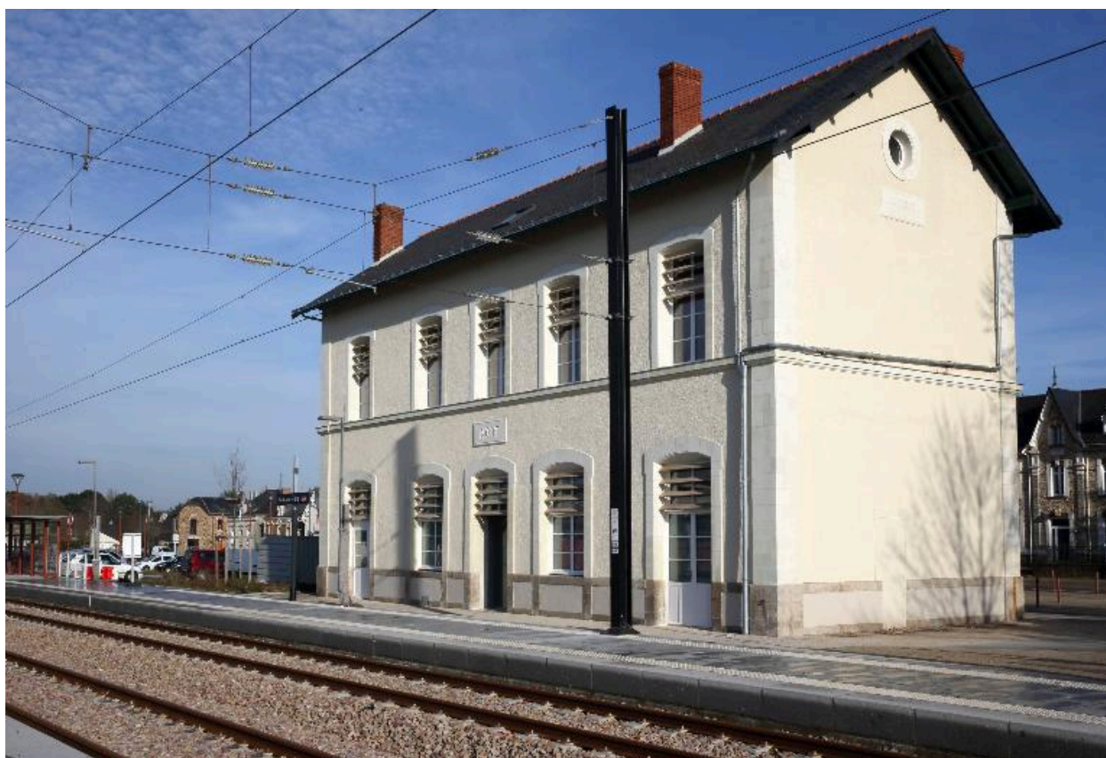
Façade côté voie après rénovation.
