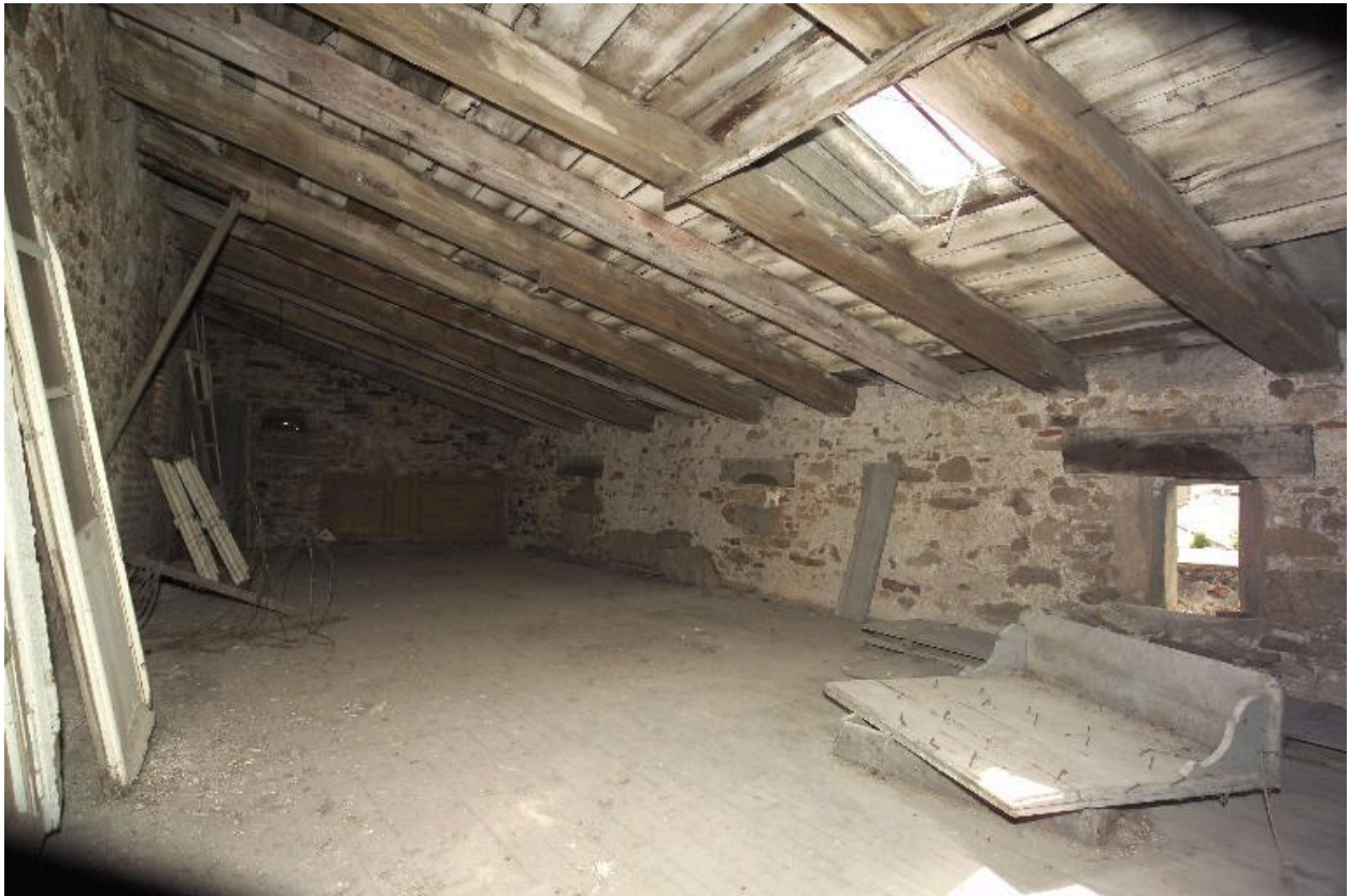
Le corps secondaire, le comble, vue prise depuis le palier.
