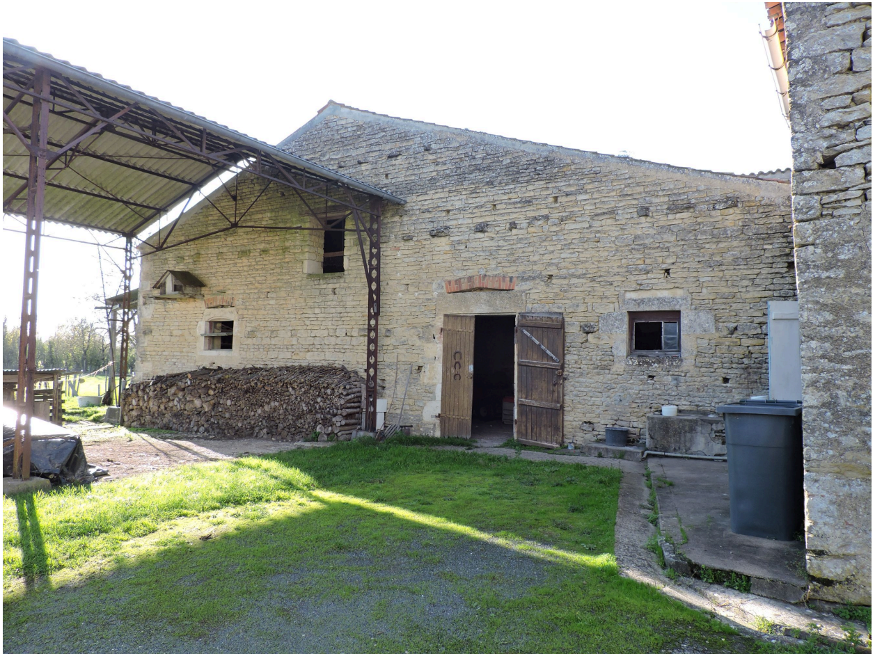
La vaste étable-écurie à façade en pignon, à l'ouest de la cour, vue depuis le nord-est.
