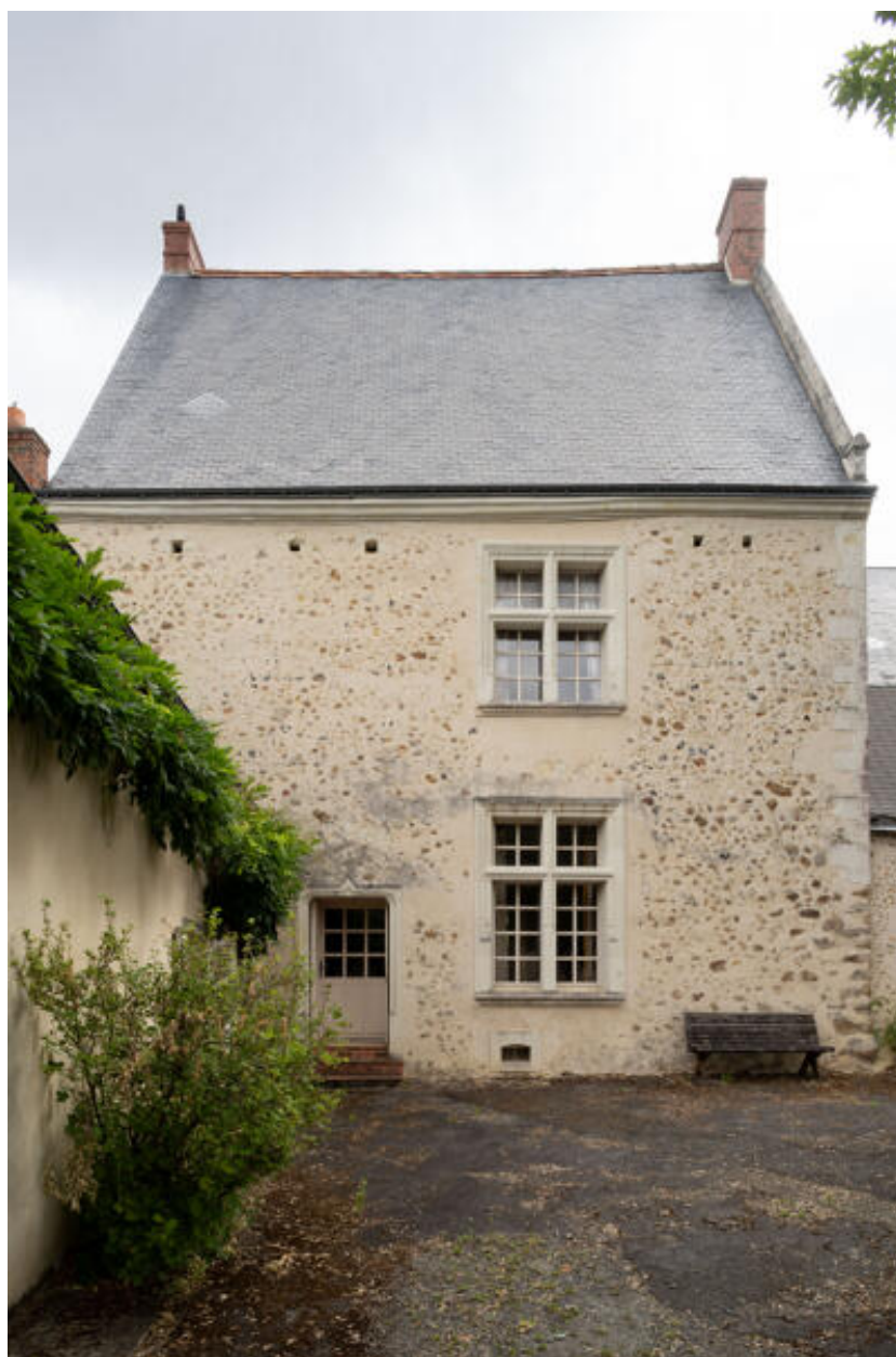
Logis à étage : façade principale.
