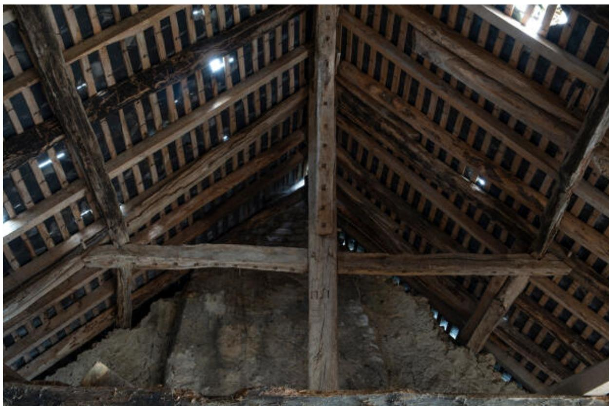
Ancien logis de la ferme des Guénardières, actuellement garage (cadastre 2024 C 247) : charpente à chevrons porteurs et pannes presque intégralement composée d'éléments provenant d'une structure à pan-de-bois. Le poinçon porte la date 1751 et la lettre M. La date pourrait correspondre au remplacement des murs en pan-de-bois du logis par des murs en moellons et à la réalisation de la charpente.
